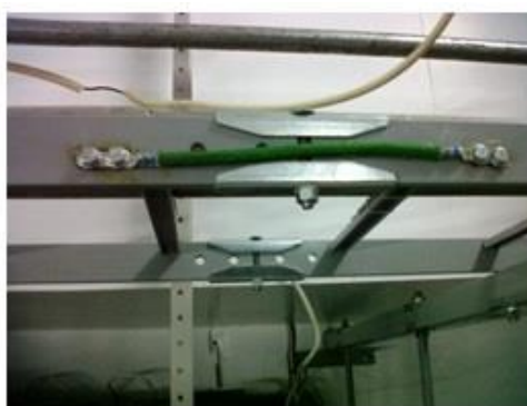
Figuur 43: Verbindingen tussen massadelen (scharnieren en kabelbanen)
