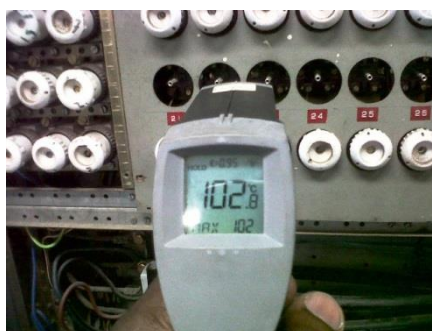
Temperatuur schroefzekering verdeelkast LA-1, groep 23.
