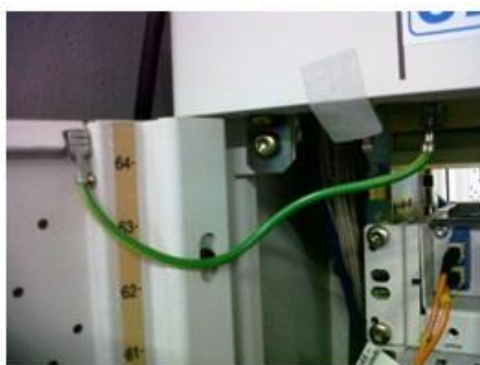
Figuur 43: Verbindingen tussen massadelen (scharnieren en kabelbanen)
